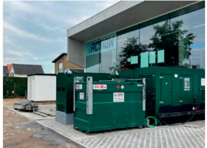
Battery Pack 90/170, geschikt voor cyclingtoepassingen: de batterij gebruikt 's nachts de overdag gestockeerde energie.
