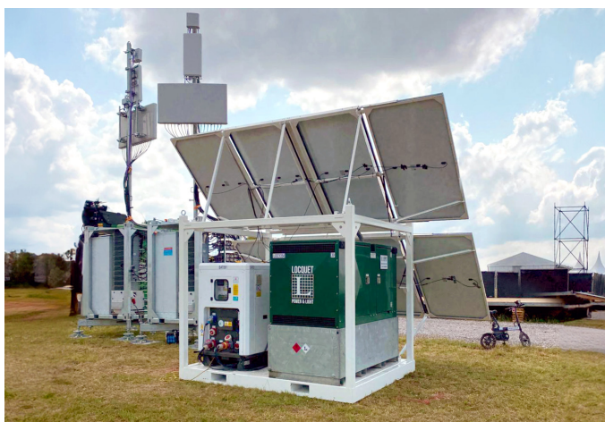
Green Solarbox 8P met Battery Pack 30/60, zonnepanelen en superstille 30 kVA Greenline noodstroomgenerator
